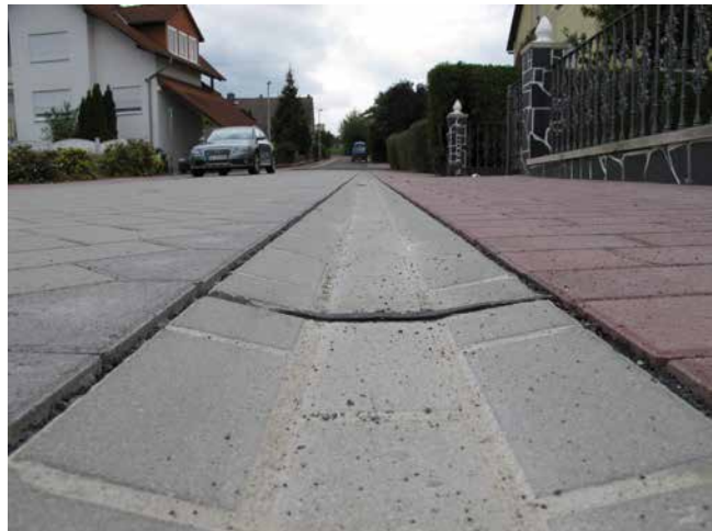
In vielen Fällen werden Straßenrinnen heute aus Betonpflasterformsteinen hergestellt.
