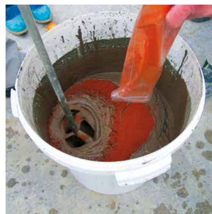
Durch Zugabe von Pigmenten lässt sich die Sopro BetonSteinFuge verschiedenfarbig einstellen.
