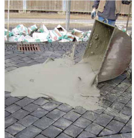
Leichtes Verfüllen der Fugen aufgrund hervorragender Verlaufseigenschaften des Fugenmörtels.
