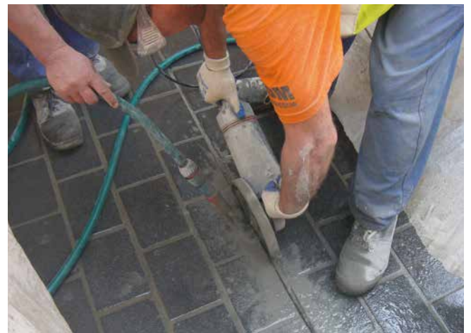
Einschneiden einer Bewegungsfuge in den Straßenbelag einige Tage nach dem Verlege- und Verfugungsprozess.
