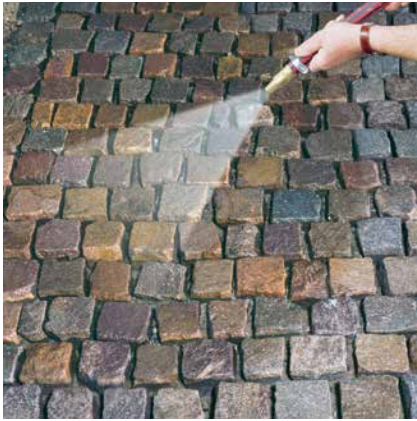
Vornässen des gereinigten, zu verfugenden Belags.
