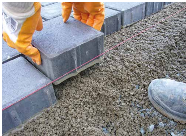
Versetzen des mit Haftbrücke vorbehandelten Steins „frisch-in-frisch“ in den vorbereiteten Bettungsmörtel Sopro DrainageMörtel.
