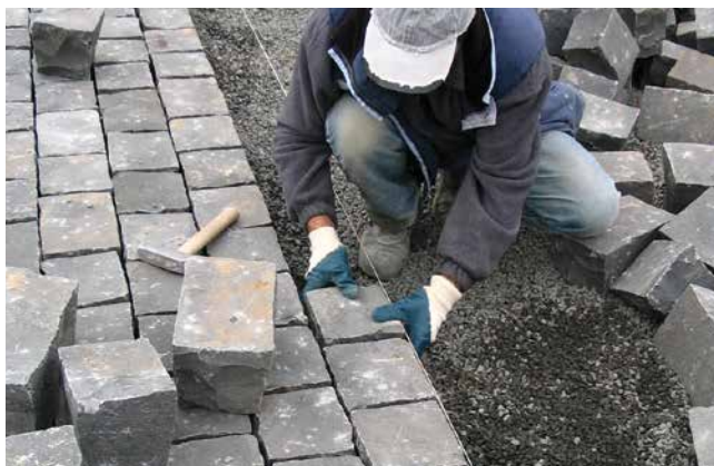
Natursteingroßpflaster für einen stark befahrenen Straßenabschnitt.
