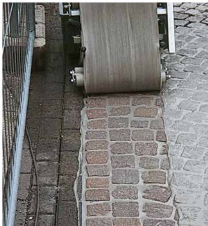
Großflächenreinigung mit Abwaschmaschine.
