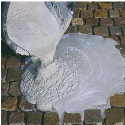
Verarbeitungsfähige Sopro EpoxiPflasterFuge 2-K.
