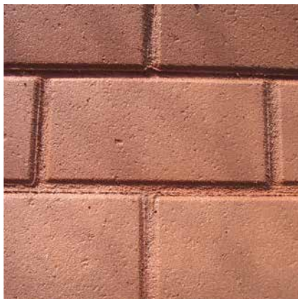
Sauber freigelegte Fase der Betonpflastersteine mit farblich durch Pigmentzugabe abgestimmtem Fugenmörtel.
