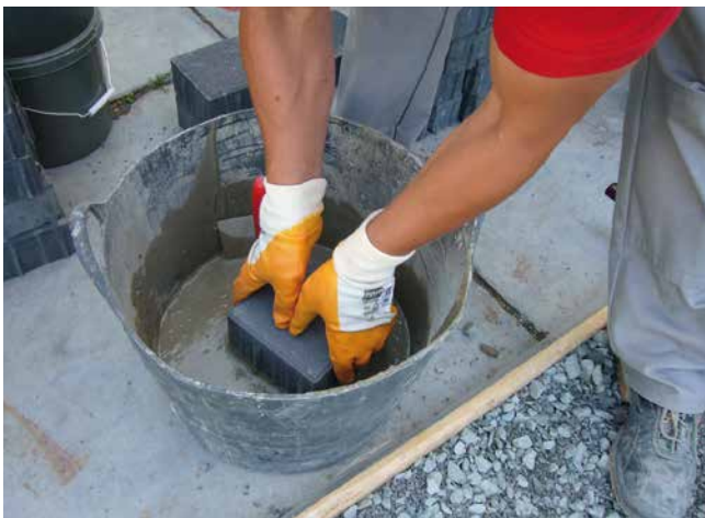
Auftragen der Haftbrücke mittels Eintauchen des Steins in die Sopro HaftSchlämme Flex.
