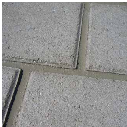
Optimal freigelegte Fase der Betonpflastersteine.
