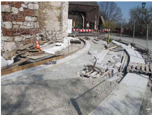
Betoniertes Rinnenfundament an einer Straße.
