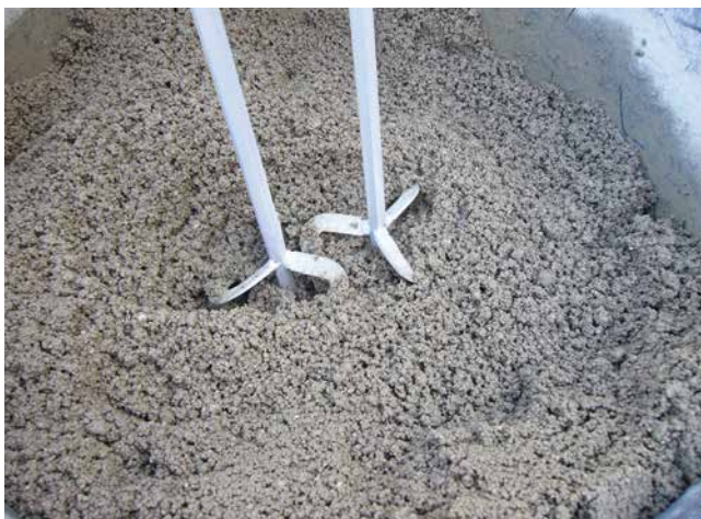
Anmischen des drainagefähigen Bettungsmörtel mit Quirl oder Zwangsmischer.
