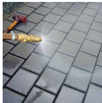
Betonsteinpflaster gut vornässen.
