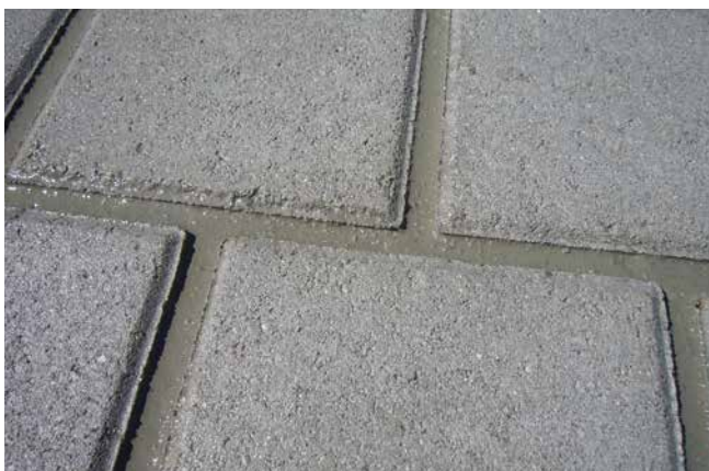
Sopro BetonSteinFuge von ihren Eigenschaften und Festigkeiten auf die Besonderheiten der Betonpflastersteine abgestimmt.
