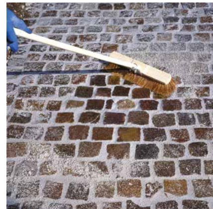
Säubern des verfugten Belags.
