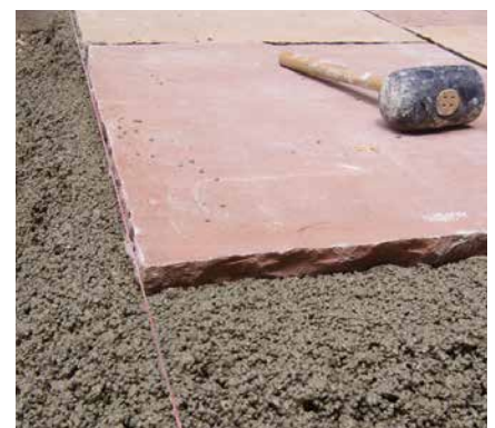
Verlegte Natursteinplatte im entsprechend dick dimensionierten Bettungsmörtel.
