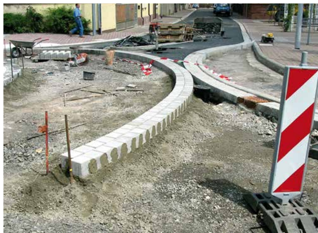
Betonpflastersteine als Rinnenbauwerk versetzt auf einem Betonfundament.
