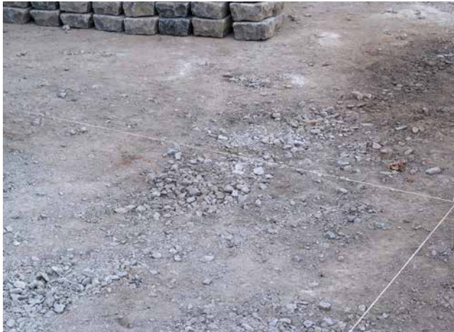
Kies-/Schotter-schicht, verdichtet bei leichter bis mittlerer Beanspruchung.
