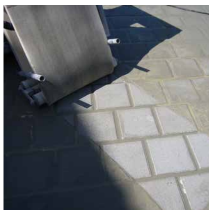
Einfaches Reinigen der Fläche mittels Schwamm- bandmaschine.
