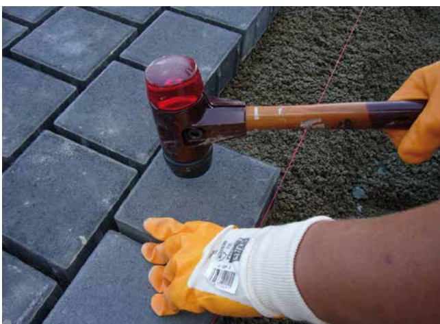
Ausrichten des Steins nach der Schnur und anschließendes hammerfestes Versetzen.
