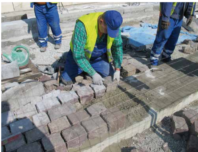
Versetzen der Natursteinpflastersteine im Verbund auf dem Balkenfundament.
