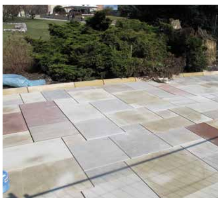
Großformatige Natursteinplatten in gebundener Bauweise verlegt.
