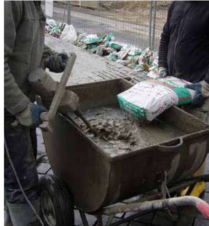
Anmischen des Fugenmörtels mittels Rührgerät.
