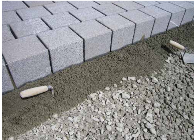
Granitpflastersteine versetzt in drainagefähigem Bettungsmörtel auf einer grobkörnigen, wasserdurchlässigen Tragschicht.
