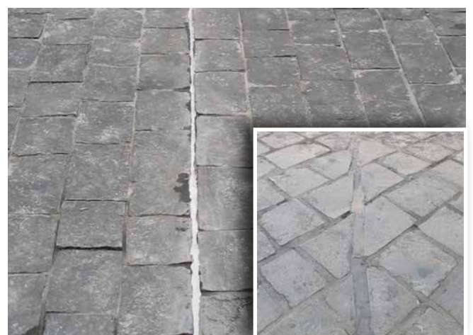
Verfüllen des Einschnitts mit Sopro PU-Dichtstoff oder Sopro TurboDichtSchlämme 2-K.
