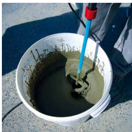
Sopro BetonSteinFuge lässt sich binnen weniger Sekunden anmischen.
