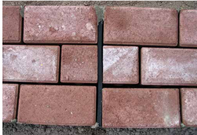
Eingebaute Gummischeibe bei Betonpflasterbelägen als Bewegungsfuge.
