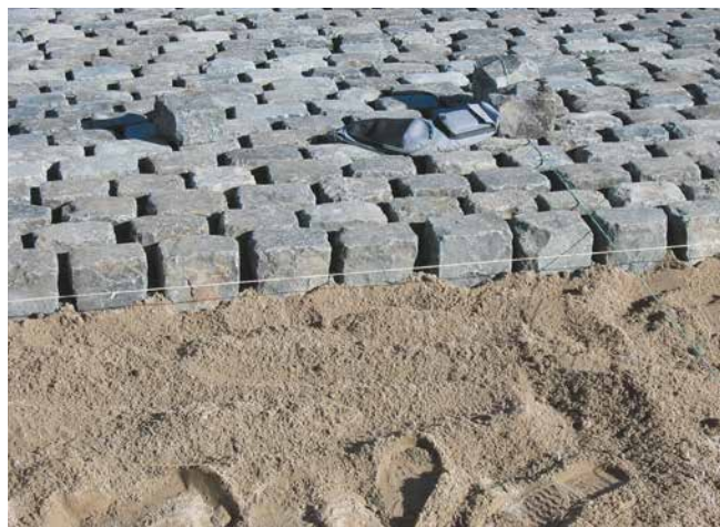
Pflastersteinverlegung mit ungebundenem Unterbau, versetzt im Sand-Kiesbett.
