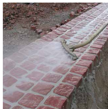
Reinigen der Fläche nach Ansteifen des Fugenmörtels mittels Sprühlanze.
