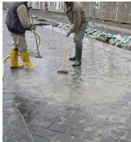
Reinigung mittels Sprühlanze.
