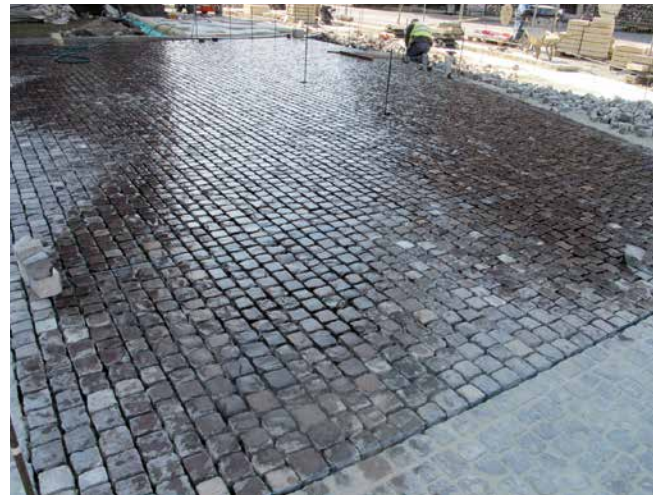
Straßenbereich, befestigt mit Natursteinpflaster.
