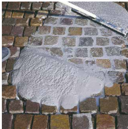
Fugenfüllendes Einbringen des Mörtels.
