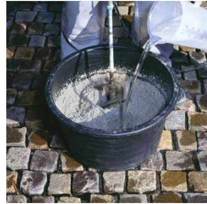
Anrühren von Sopro EpoxiPflasterFuge 2-K mit Zugabe von Wasser.
