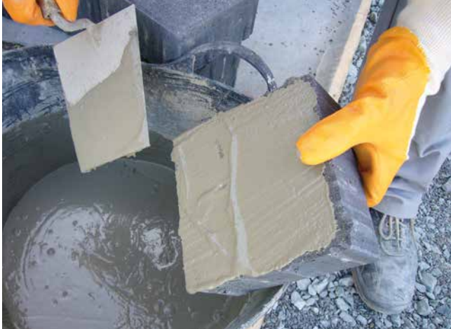
Auftragen der Haftbrücke (Sopro HaftSchlämme Flex) mittels Kelle auf der Rückseite des Steins.
